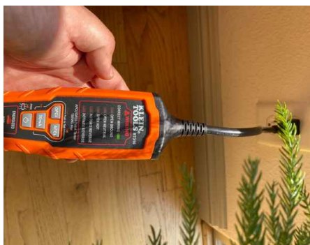
GFCI & AFCI: AFCI
